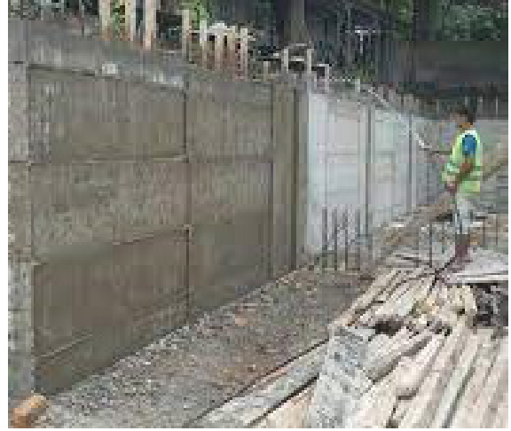
Şekil-9. Beton 7x2 gün/defa sulanmalıdır.
